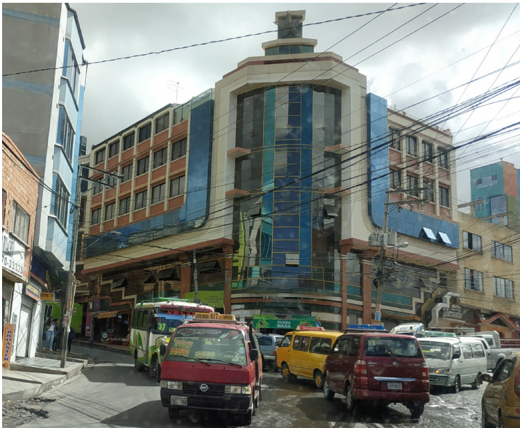
Fig. 6. Los salones de fiesta El Zar (arriba) y Venecia (abajo), construidos antes de 2002, ya presentan rasgos estéticos y espaciales que se expandirán con mayor fuerza en la ciudad de El Alto. Fotografía: © Guido Alejo.
