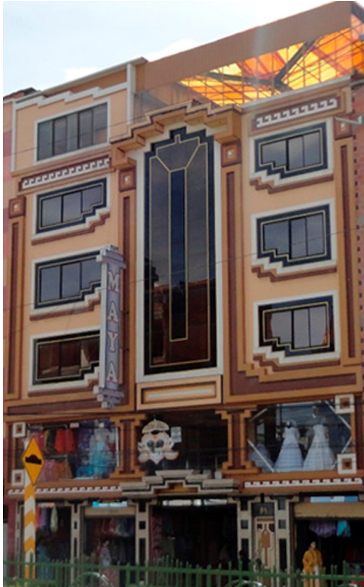
Fig. 5. Galeria Maya, ubicada en la Av. Alfonso Ugarte, en la zona 16 de Julio, El Alto. Es una de las obras de Miguel Prieto. Nótese el uso de la figura escalonada y los colores terracotas. La última planta es una adición posterior. Fotografía: © Guido Alejo.
